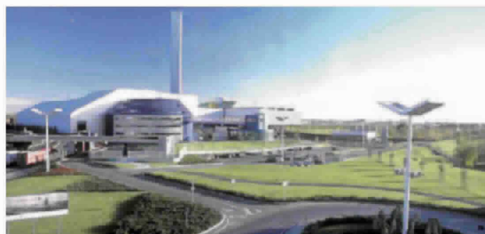
Rifiuti. Il termovalorizzatore di Brescia
