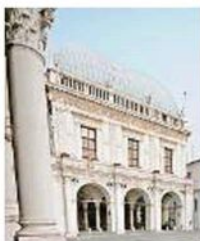
Nella fotografia, Palazzo Loggia
