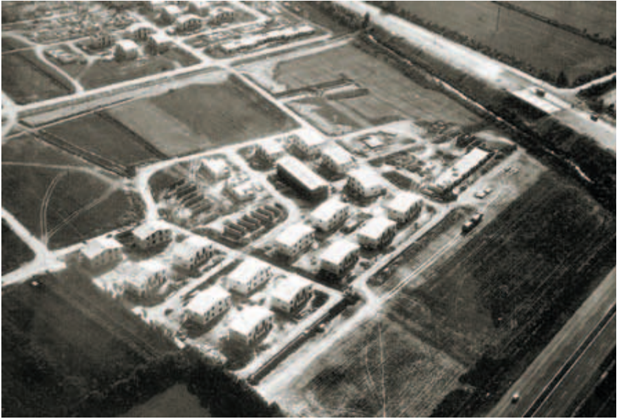
Le prime villette del Villaggio Sereno, realizzate a ridosso dell'autostrada e di via Labirinto.
